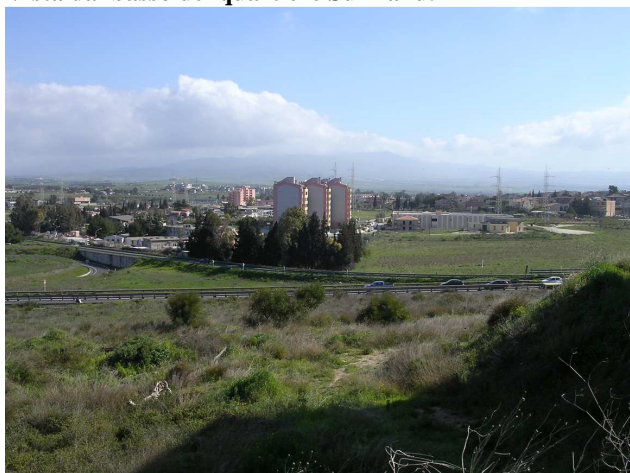
Vista dal quartiere Su Planu dello svincolo a quadrifoglio e del quartiere Is Corrias nello sfondo.
