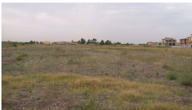
Vista dal basso della Zona Urbanistica Omogenea C3.1, in adiacenza alle C1 attuate o in corso di attuazione.
